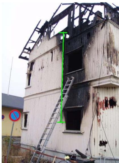
Fig. 4. Utvendig utfellbar rømningsstige er markert med grønn farge. Underkant vindu på loftet er ca. 8 meter over planert terreng (målt på tegning). Stigen er avsluttet ca. 2 m over terreng.
