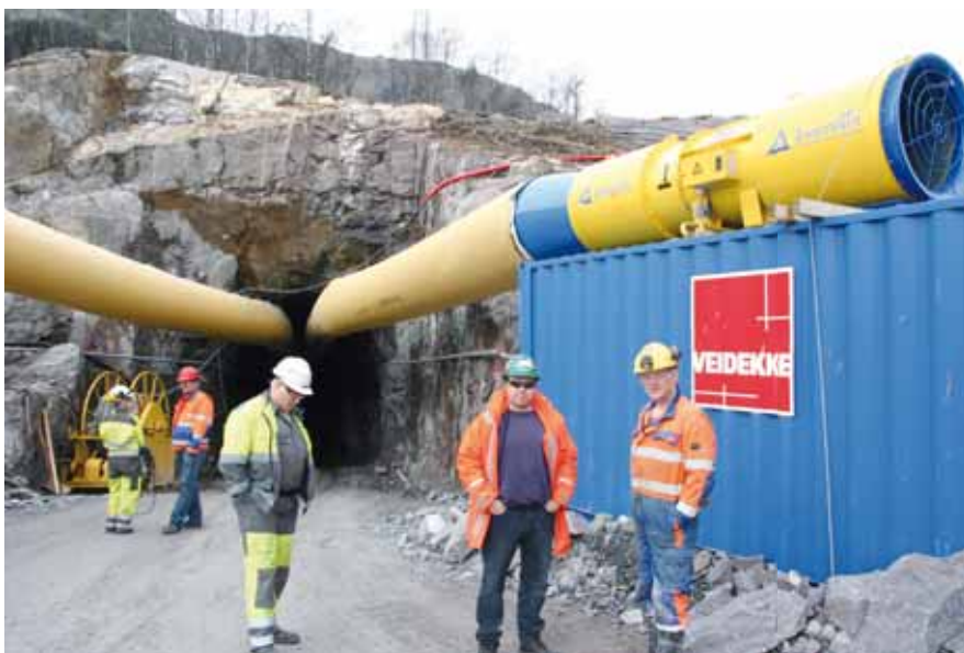
VEIEN INN: Her blir gjestene vist inngangen til den tre kilometer lange tunnelen som skal sikre det nye dagbruddet 60 års drift.
