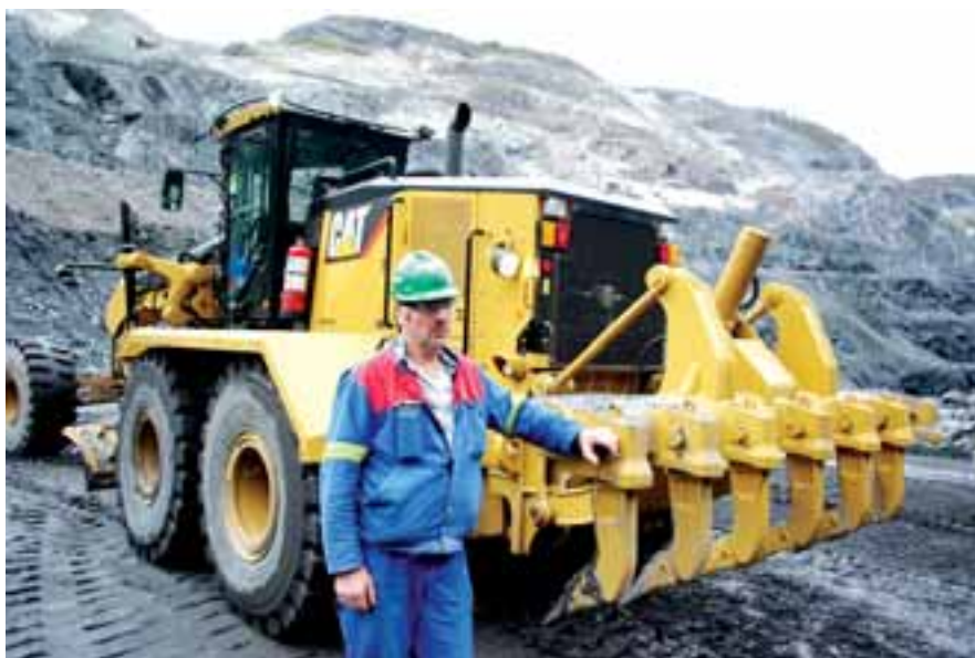
SV/ER: – Disse skal brukes til å rippe opp grunnen før vi skrapper når veien er ujevn, sier Tønnes Omdal.
