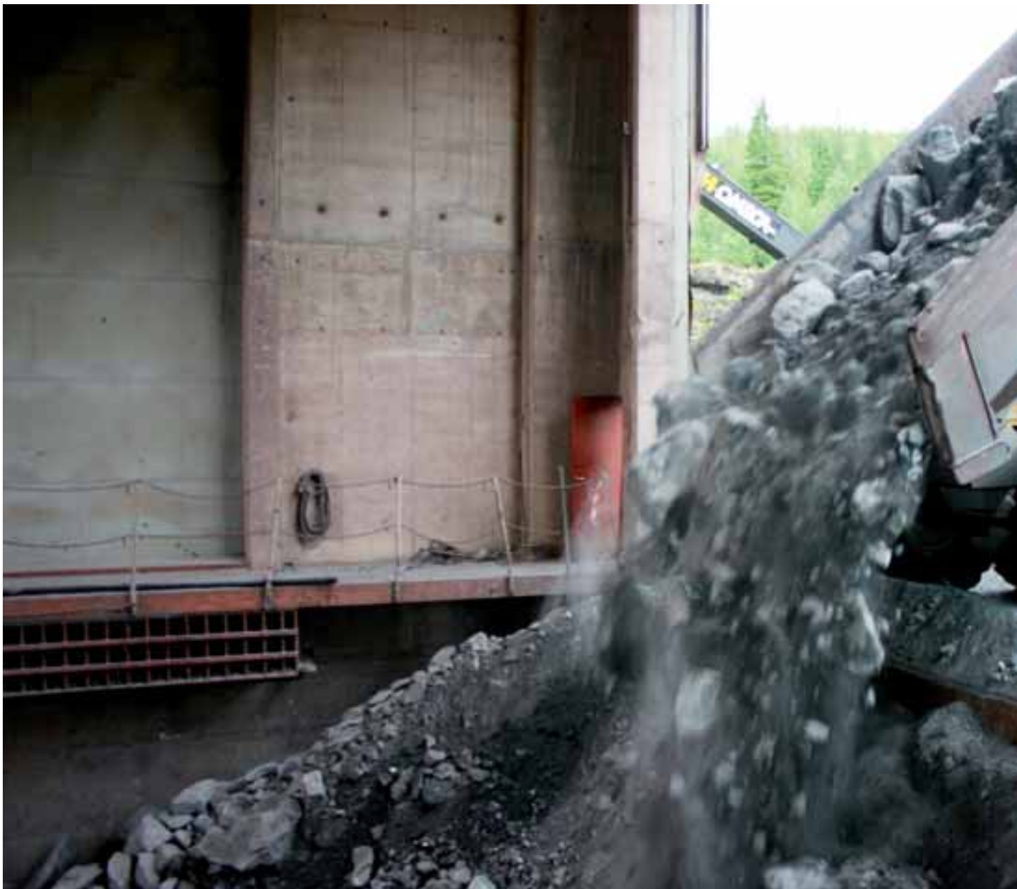
KNUSEREN: Malmen blir i dag kjørt ut til knuseren. Men med det nye driftsnivået må man også bygge en ny steinknuser inne i en stor fjellhall, fordi avstanden opp til dagen blir for lang.
